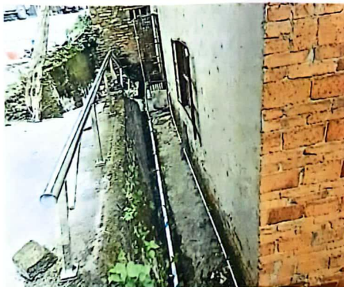
图二：建卫生间，安装热水器，挖建排污管道
