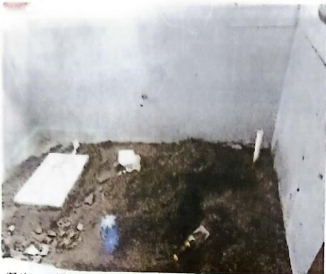
图片一：原厕所地面沉池拆除及排水排污管改造
